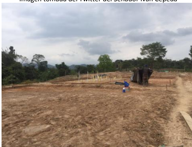
Estado de las obras de adecuación de la ZVTN de Caño Indio (Tibú) Imagen tomada del Twitter del Senador Iván Cepeda
